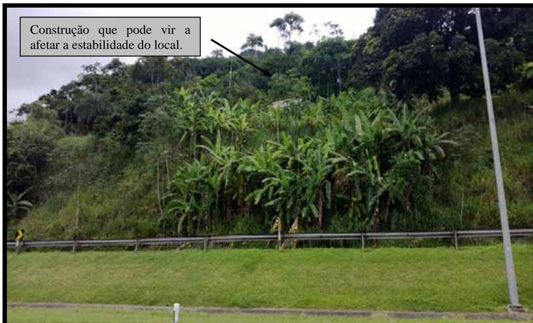
**Figura 5.28:** Presença de bananeiras evidenciando a existência de camada de solo coluvionar. Indicação de antropismo no local – km 16,4 da BR-116/RJ. Foto: 21/12/2013.
