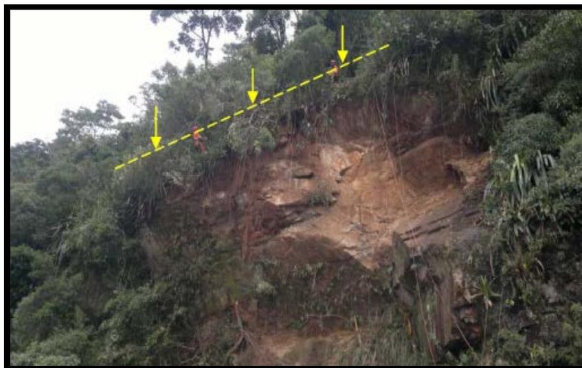
**Figura 7:** Trinca na crista do corte (BR-116/RJ, km 90,1).
