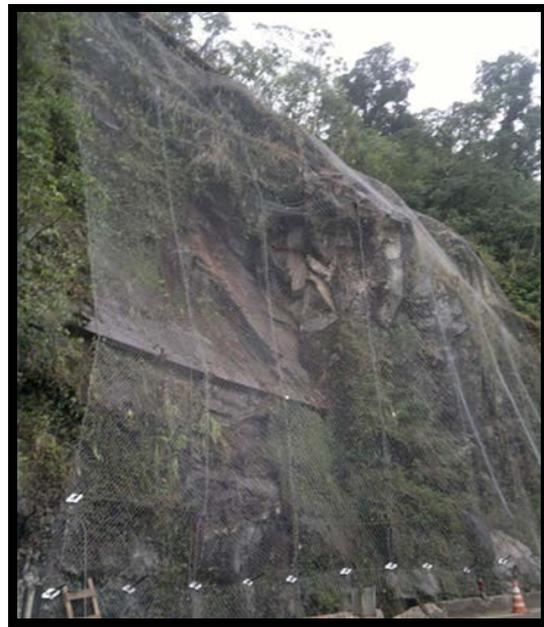
**Figura 5.19:** Entelamento fixado com chumbadores (tela de arame 3mm de aço carbono de alta resistência) – km 89,9 da BR-116/RJ.
