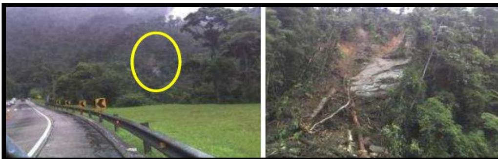
**Figura 1:** Vista geral e detalhe de deslizamento translacional de solo superficial assente diretamente sobre maciço rochoso pouco alterado, ocorrido no km 91,050, no dia 21 de janeiro de 2009. **Fonte:** d'Orsi, 2011.
