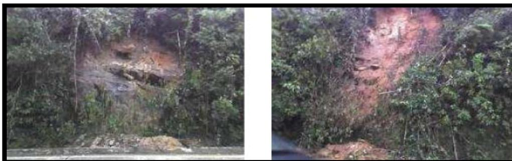
**Figura 2:** Vistas de deslizamentos translacionais de pequeno porte, envolvendo capa de solo superficial (provável colúvio sobre solo residual) assente diretamente sobre maciço rochoso pouco alterado. Os movimentos ocorreram nos km 90,400 e 90,480 em algum momento entre os dias 21 e 22 de janeiro de 2009. **Fonte:** d'Orsi, 2011.
