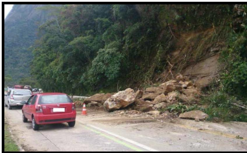
**Figura 4:** Blocos na pista (BR-116/RJ, km 90,1).
