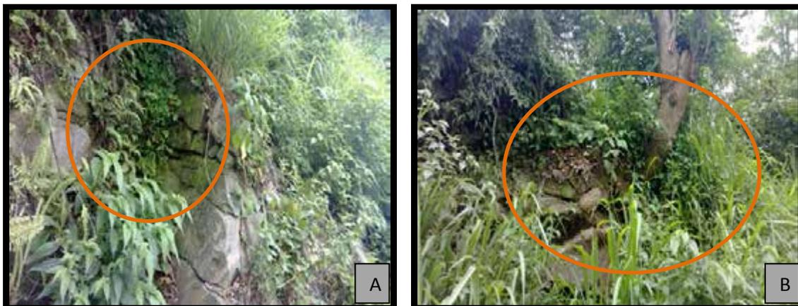
**Figura 5.29:** Fotos da encosta demonstrando a situação instável do local – possível queda de blocos na pista (altura do km 116,4 da BR-116/RJ).
