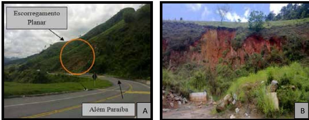
**Figuras 5.8:** Deslizamento planar ocorrido no km 29 da Rodovia BR-116/RJ (imagem A). Demonstração da semelhança geológica entre os segmentos estudados (imagem B).
