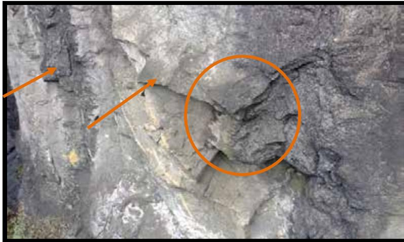
**Figura 5.17:** Trincas e fraturas na rocha – km 90 da BR-116/RJ.
