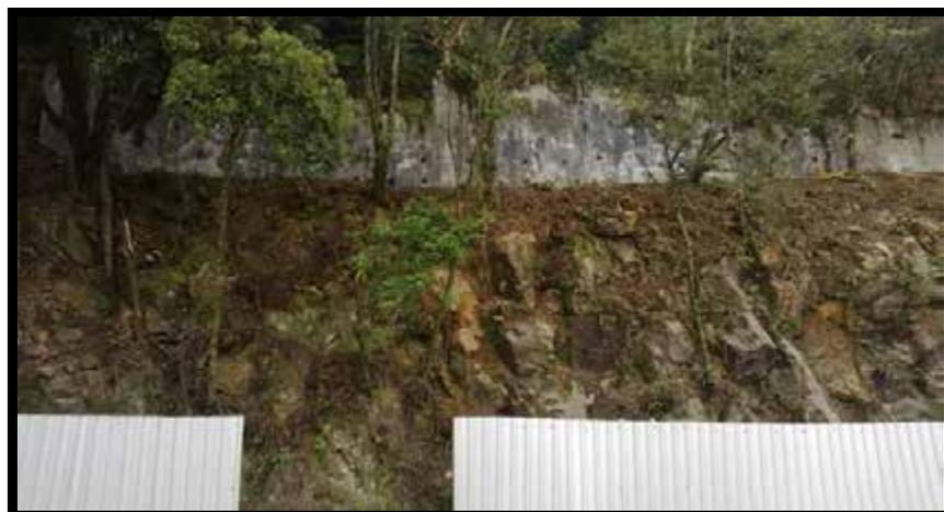
**Figura 5.21:** Local propenso a escorregamentos planares e à queda de blocos – km 93,8 da BR-116/RJ. Foto: 19/09/2013.
