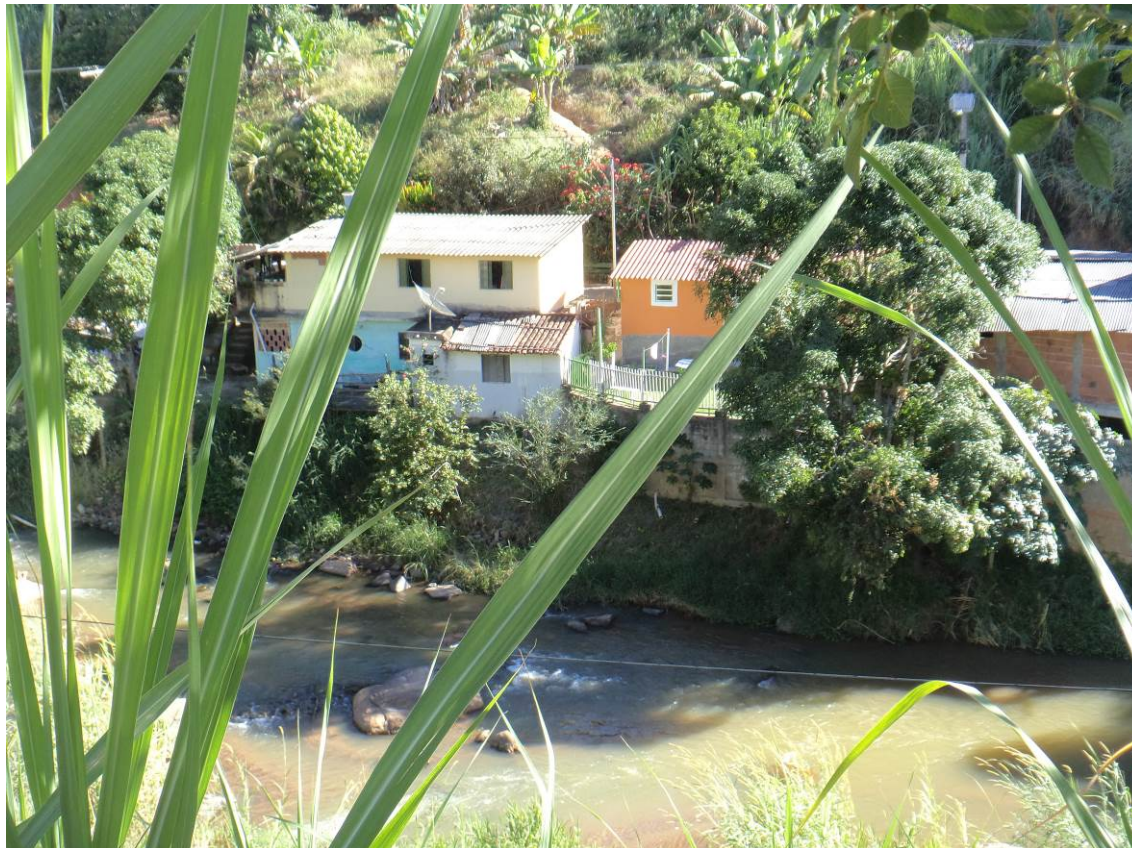
Figura 33 – Residências as margens do rio Paquequer
