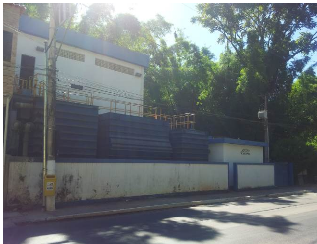
Figura 4 – Estação de Tratamento Sumidouro.
