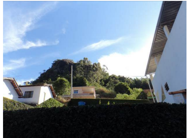
Figura 25 – Casas na base do maciço com risco de deslizamento.
