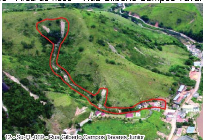
Figura 30 - Área de risco – Rua Gilberto Campos Tavares Junior.
