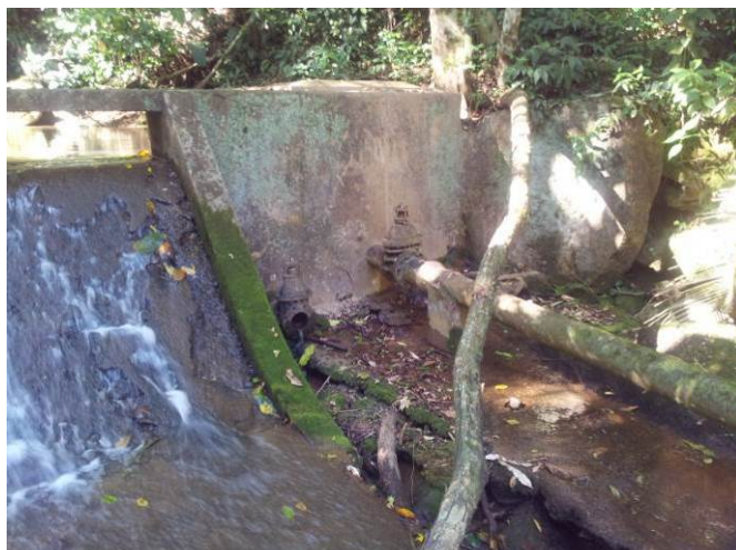
Figura 2 – Captação na barragem – Córrego de São Caetano
