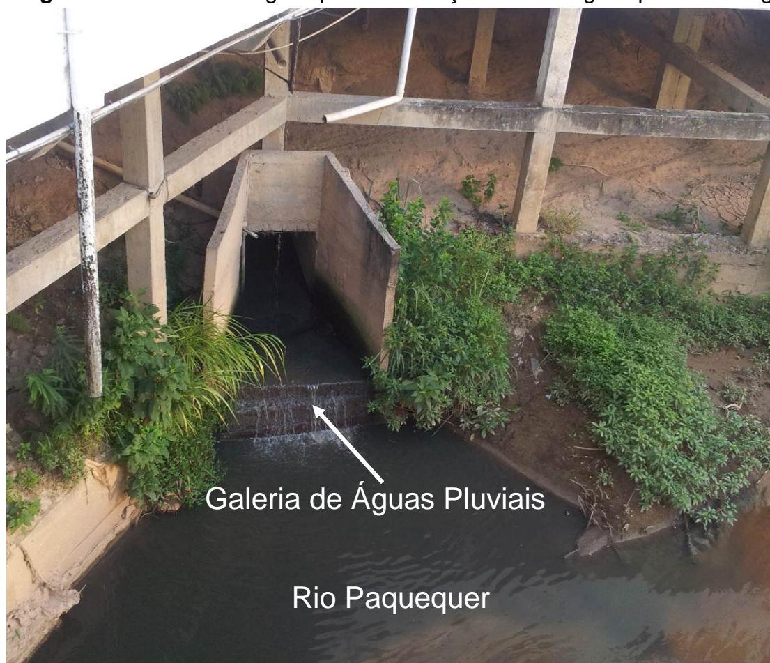
Figura 20 – Galeria de águas pluviais – lançamento de águas pluviais e esgoto.
