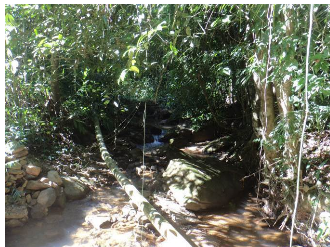
Figura 3 – Tubulação de água bruta captada
