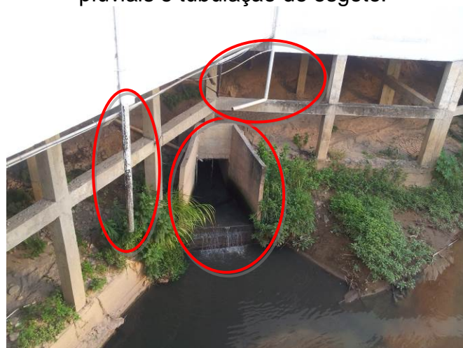
Figura 17 – Exemplo de Galeria de águas pluviais e tubulação de esgoto.
