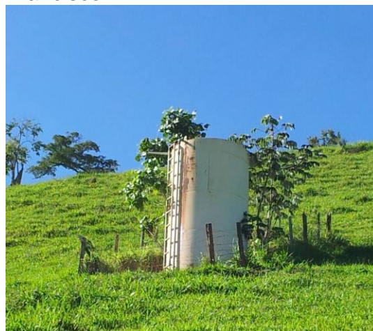
Figura 27 - Reservatório Barra de São Francisco
