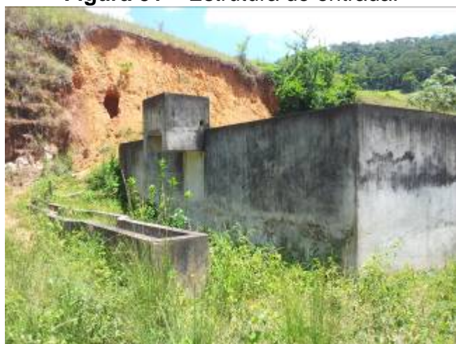
Figura 51 – Estrutura de entrada.
