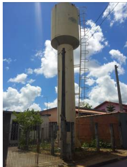
Figura 25 – Reservatório Bom Pastor.
