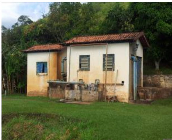
Figura 7 - Estação Elevatória de água Bruta.
