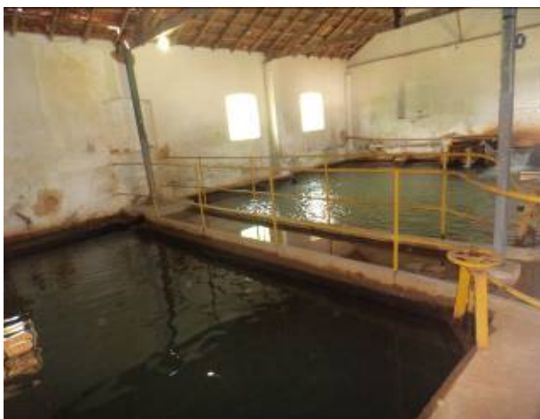
Figura 22 – Reservatório (200 m 3 ) da ETA Batalha.
