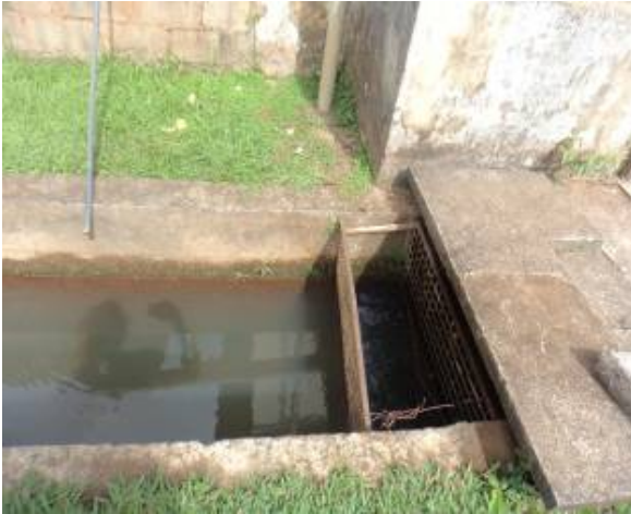
Figura 3 – Captação Rio Batalha.
