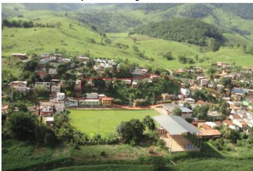
Figura 72 - Área de risco na Rua Djandiro Rodrigues da Silva – Porto Velho do Cunha.
