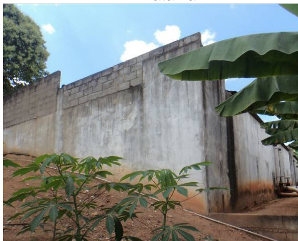
Figura 23 – Reservatório (900 m 3 ) da ETA Batalha.
