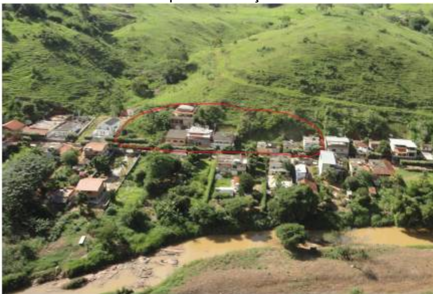
Figura 71 - Área de risco na Rua Joaquim Lourenço de Carvalho – Porto Velho do Cunha.
