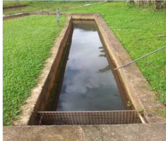
Figura 4 - Vista frontal da captação
