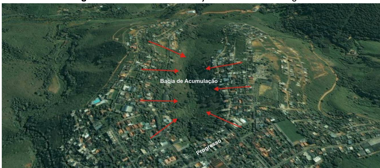
Figura 66 – Bacia de acumulação localidade de Progresso.
