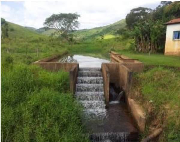
Figura 5 – Vista frontal da captação.
