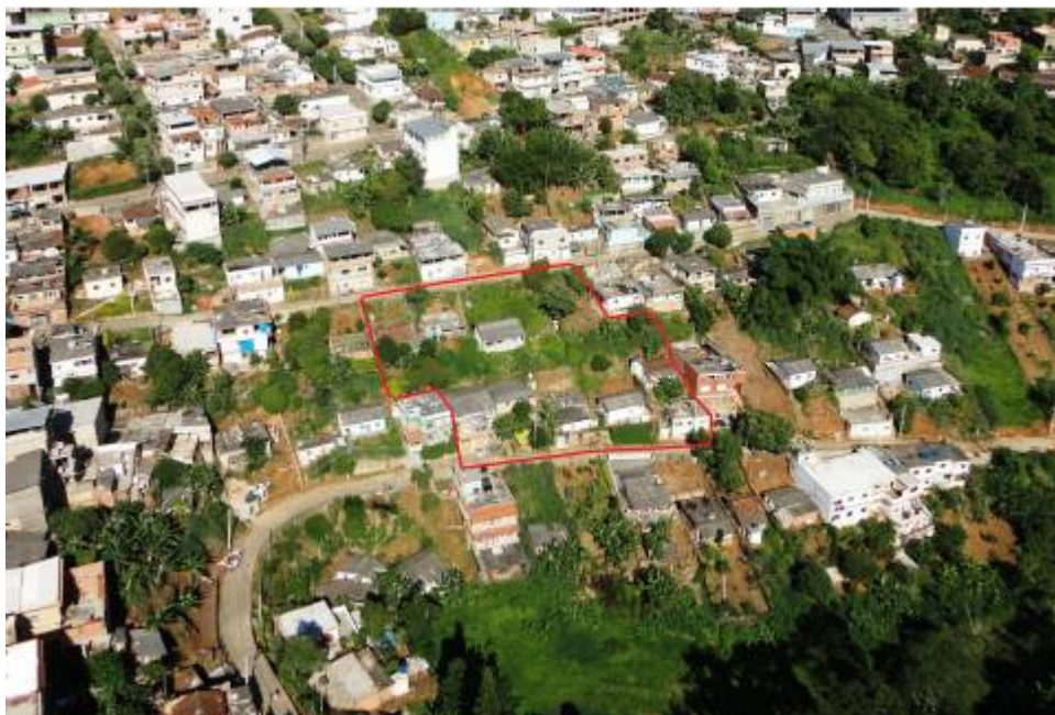
Figura 69 – Área de risco na Rua Sebastião Ataíde de Melo – Bairro Botafogo.
