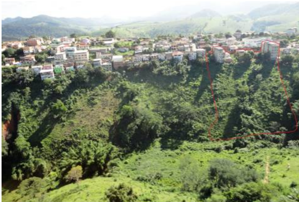
Figura 68 – Área de risco na Rua Celso Carrilhos de Farias – Bairro São Geraldo.
