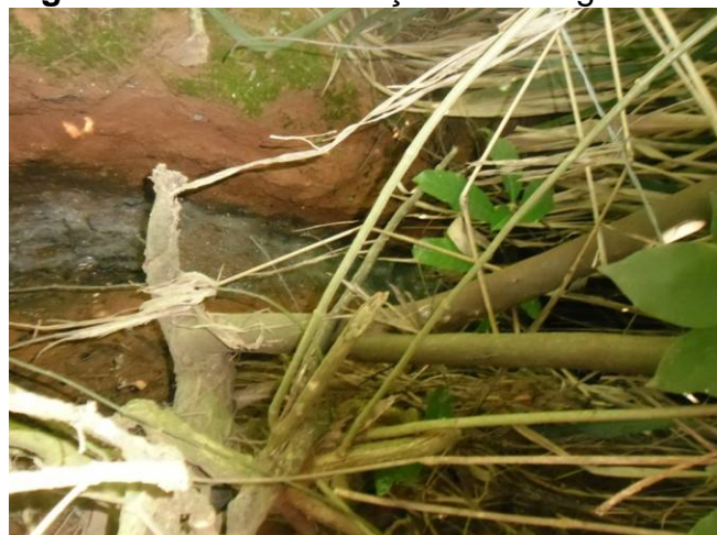
Figura 47 -Ponto de Lançamento-Esgoto 01
