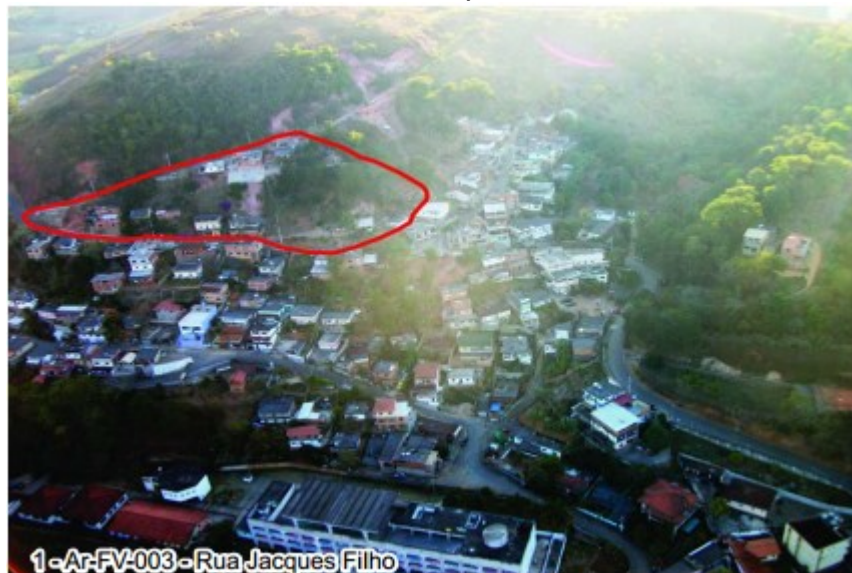
Figura 32 – Área de risco na Rua Jacques Filho – Bairro São Sebastião.
