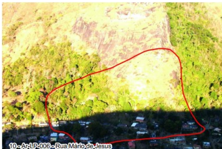
Figura 34 – Área de risco na Rua Mário de Jesus – Bairro Vila Adelaide.
