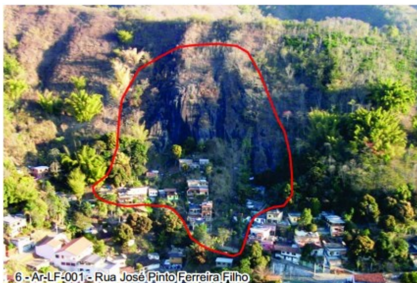
Figura 33 – Área de risco na Rua José Pinto Ferreira Filho – Bairro Gaby.
