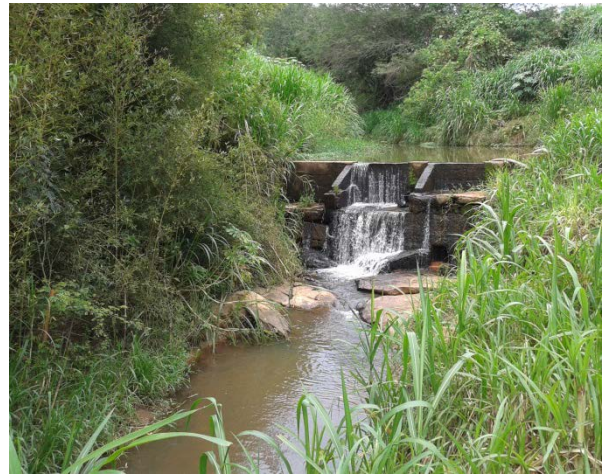
Figura 5– Vista frontal da captação
