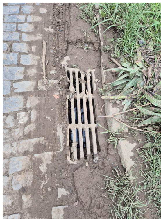
Figura 19 - Dispositivos de microdrenagem (bocas de lobo) no entorno do Lago Quitantinha Fonte: Vistoria realizada em 12/12/2024
