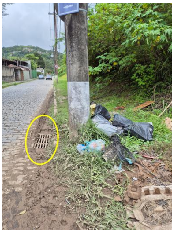
Figura 19 - Dispositivos de microdrenagem (bocas de lobo) no entorno do Lago Quitantinha Fonte: Vistoria realizada em 12/12/2024
