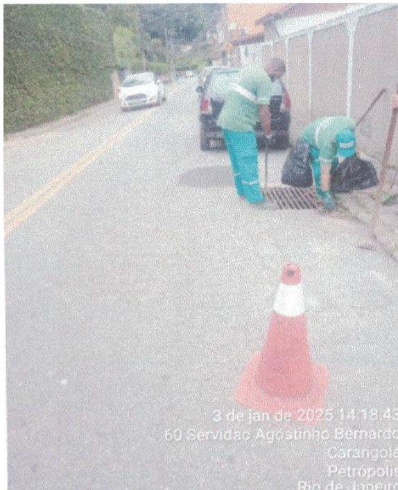
Figura 60 – Limpeza de dispositivos de drenagem urbana pela COMDEP, em janeiro de 2025. Fonte: COMDEP (2025)
