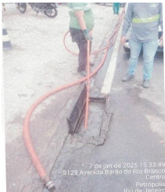
Figura 61 – Limpeza e desobstrução de rede de drenagem com caminhão Vac-All. Fonte: COMDEP (2025)
