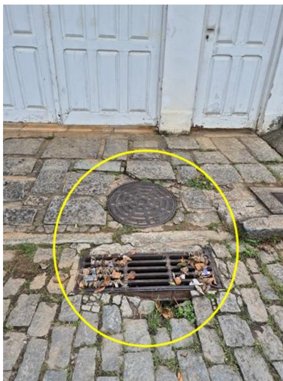
Figura 17 - Dispositivos de microdrenagem (bocas de lobo e poço de visita) no bairro do Quitandinha. Fonte: Vistoria realizada em 12/12/2024
