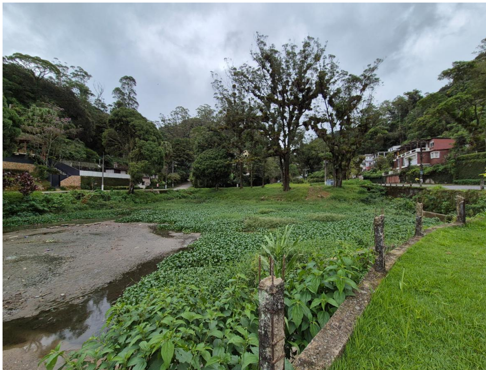
Figura 38 - Lago de Baixo São Vicente (Rio do Major Acher) - Vista para montante Fonte: Vistoria realizada em 12/12/2024
