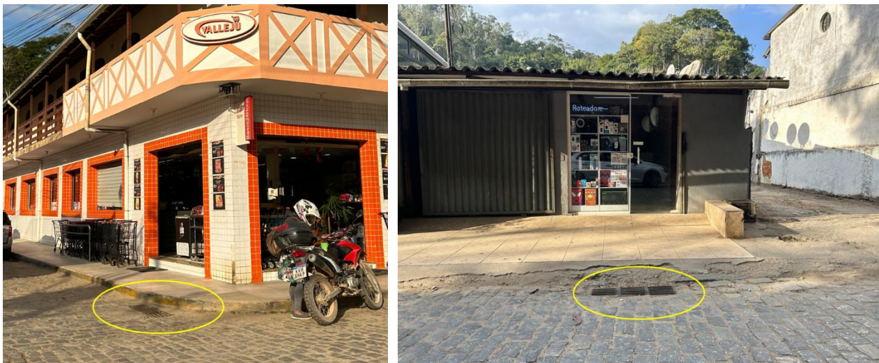
Figura 22 - Bocas de lobo em Secretário Fonte: Vistoria realizada em 25/06/2024
