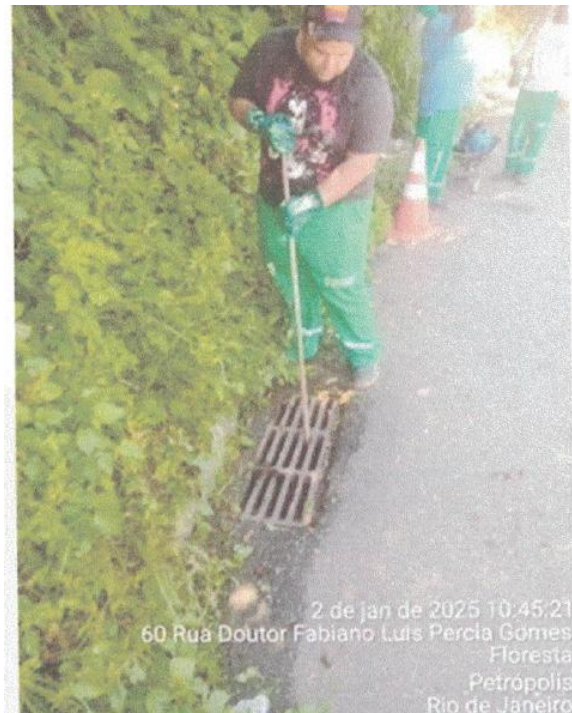
Figura 59 – Limpeza de dispositivos de drenagem urbana pela COMDEP, em janeiro de 2025. Fonte: COMDEP (2025)
