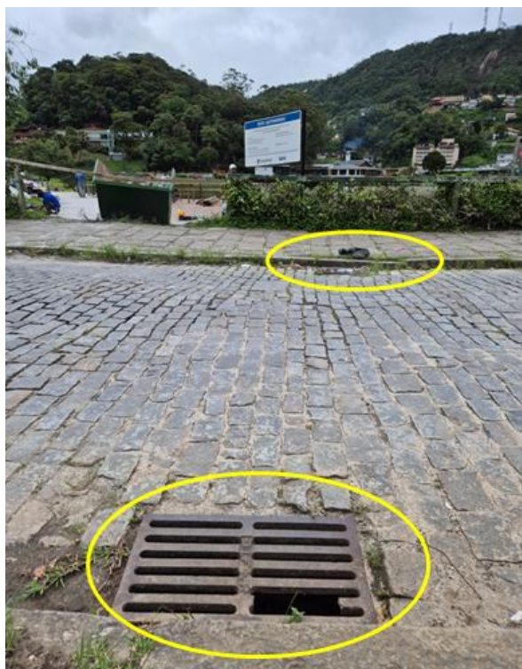
Figura 18 - Dispositivos de microdrenagem (bocas de lobo) no entorno do Lago Quitandinha Fonte: Vistoria realizada em 12/12/2024
