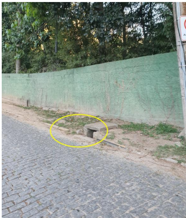
Figura 23 - Microdrenagem (Bocas de lobo, caixa coletora) em Itaipava Fonte: Vistoria realizada em 30/04/2024
