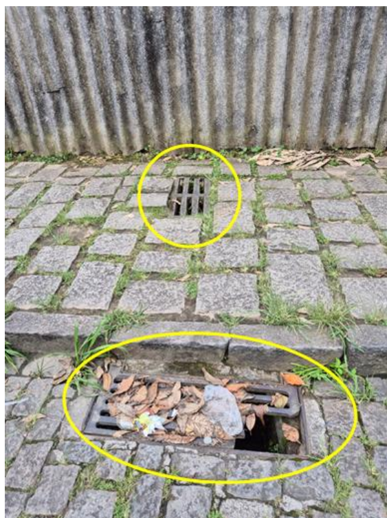
Figura 17 - Dispositivos de microdrenagem (bocas de lobo e poço de visita) no bairro do Quitandinha. Fonte: Vistoria realizada em 12/12/2024
