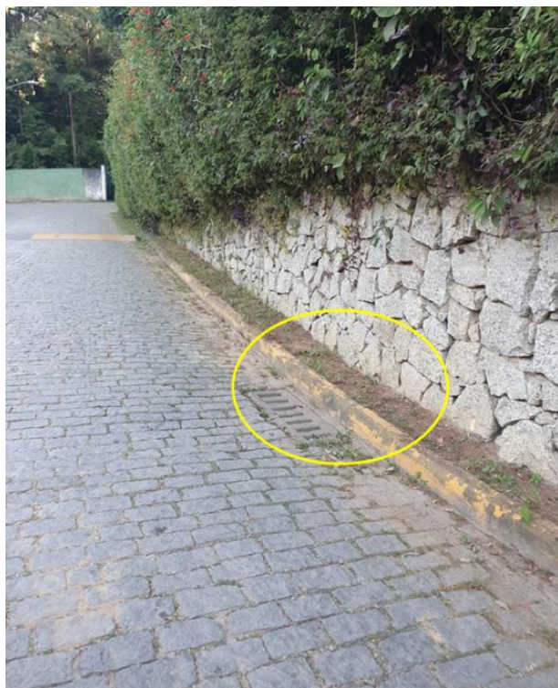
Figura 23 - Microdrenagem (Bocas de lobo, caixa coletora) em Itaipava Fonte: Vistoria realizada em 30/04/2024
