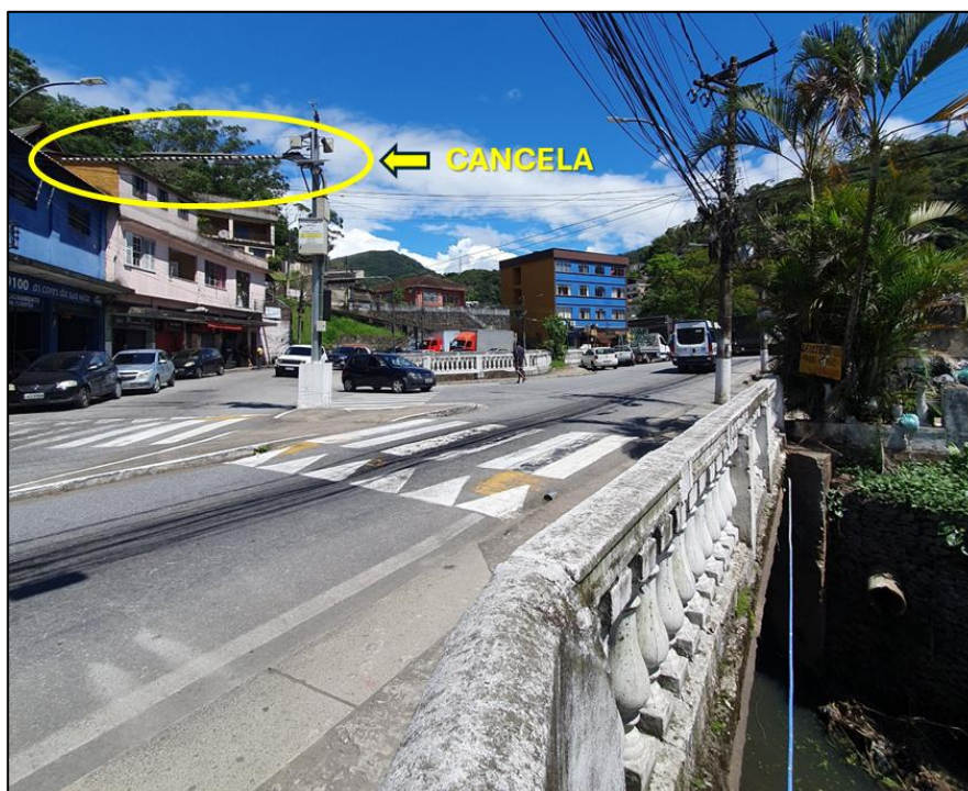
Figura 63 – Cancela utilizada pela Defesa Civil, para bloqueio da rua Cel. Veiga em casos de inundação decorrentes do extravasamento do rio Quitandinha. Fonte: Vistoria realizada em 06/11/2024
