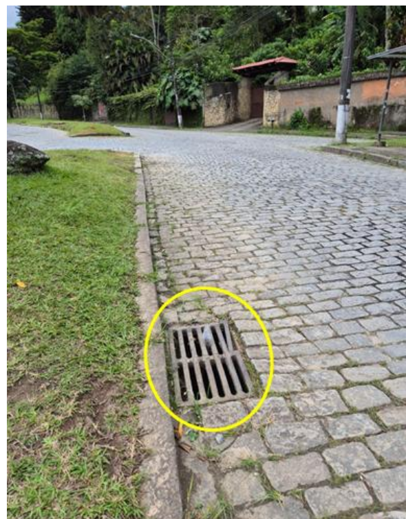
Figura 18 - Dispositivos de microdrenagem (bocas de lobo) no entorno do Lago Quitandinha Fonte: Vistoria realizada em 12/12/2024
