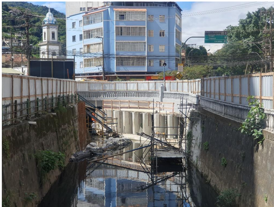
Figura 44 – Entrada do Túnel Extravasor Fonte: Vistoria realizada em 06/11/2024
