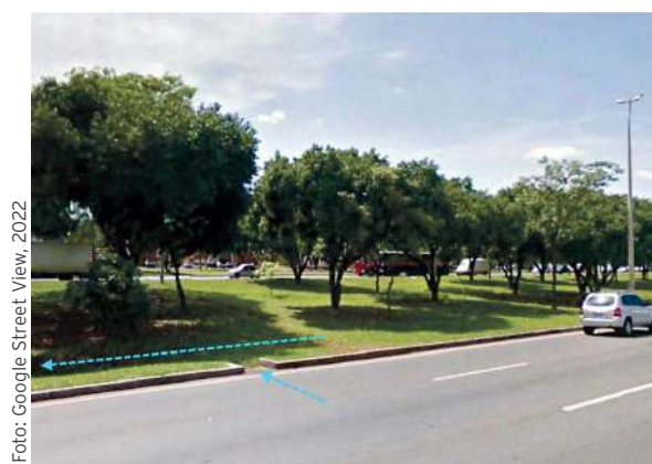
Figura 41 Canteiro central da via DF003/EPIA, com captação de águas pluviais e vala de infiltração gramada no canteiro central.
