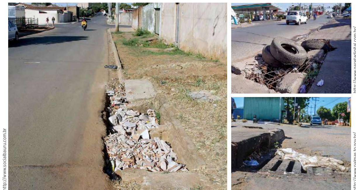
Figura 7 Impactos de lançamentos de resíduos sólidos em bocas de lobo e redes de drenagem urbana.
