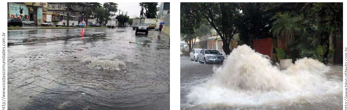
Figura 8 Impactos de lançamentos de águas pluviais em redes de esgotos.
