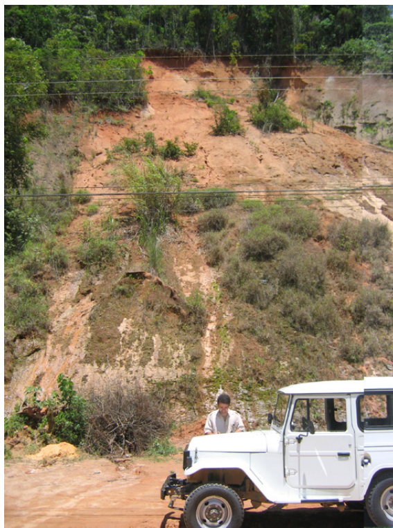
Figura 23 – Escorregamento onde ainda pode-se observar material deslizado sobre o contato solo/rocha. Ocorrido em Janeiro de 2004 próximo ao pedágio em direção a Além Paraíba, reativado entre Novembro e Dezembro de 2005.
