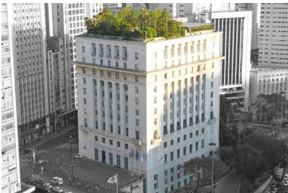
Figura 09: Construção Semi intensiva Ed. Conde Matarazzo, Sp.
