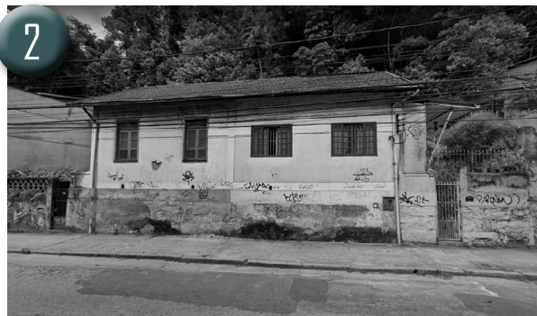
Figura 73: Residência antes do dia 15/02/2022.
