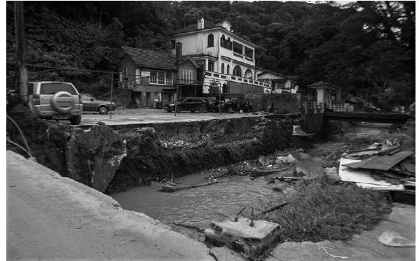
Figura 72: Trecho viário após dia 15/02/2022.
