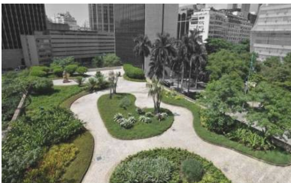
Figura 10: Construção intensiva Terraço do Palácio Gustavo Capanema, Rj.
