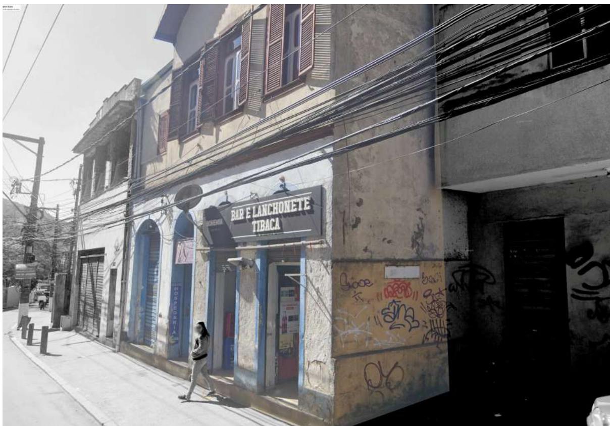
Figura 114: Edifício tombado números 269 e 273.
