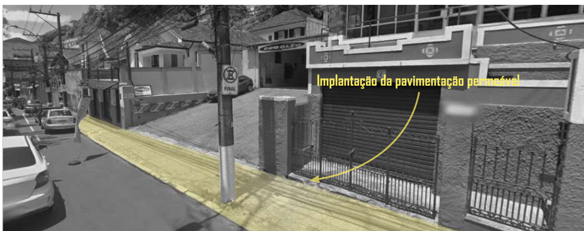
Figura 161: Pavimentação permeável ao longo de toda Rua Washington Luís.
