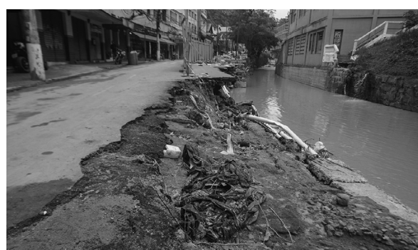
Figura 86: Trecho viário após dia 15/02/2022.
