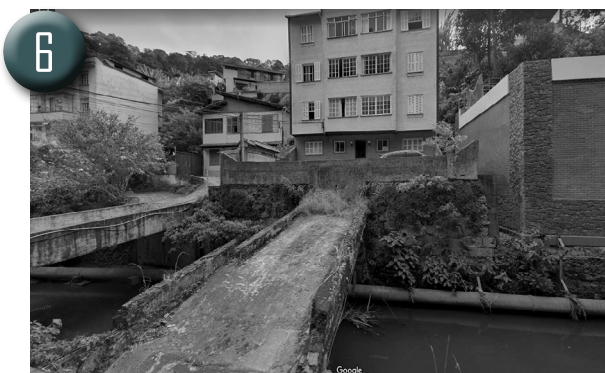
Figura 81: Ponte edificada antes do dia 15/02/2022.
