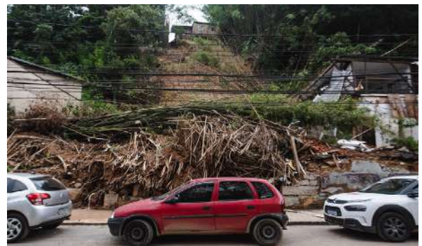
Figura 74: Residência após dia 15/02/2022.
