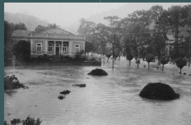
Figura 58: Inundação na praça Visconde de Mauá (da água) em 20 de março de 1930.
