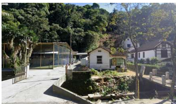
Figura 131: Vazio Urbano (Deslizamento de massa).
