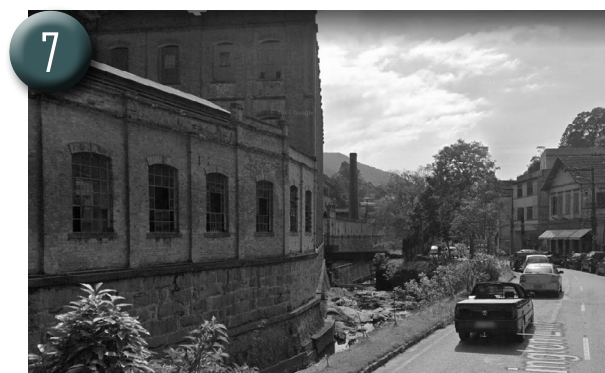
Figura 83: Trecho viário antes do dia 15/02/2022.
