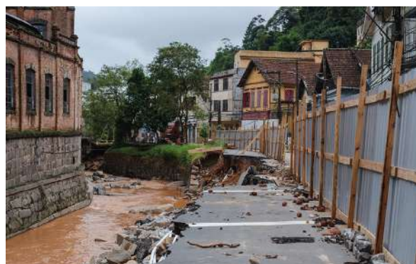
Figura 84: Trecho viário após dia 15/02/2022.
