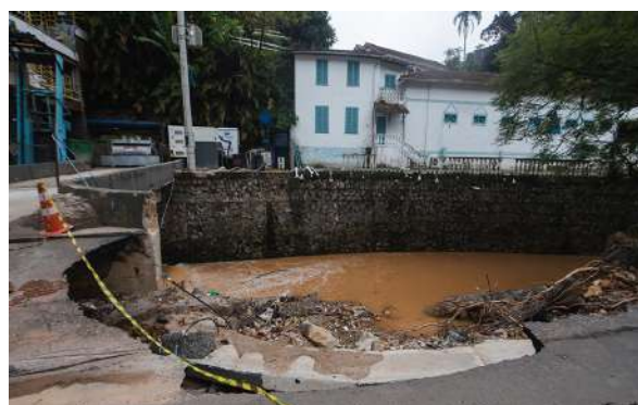
Figura 80: Trecho viário após dia 15/02/2022.
