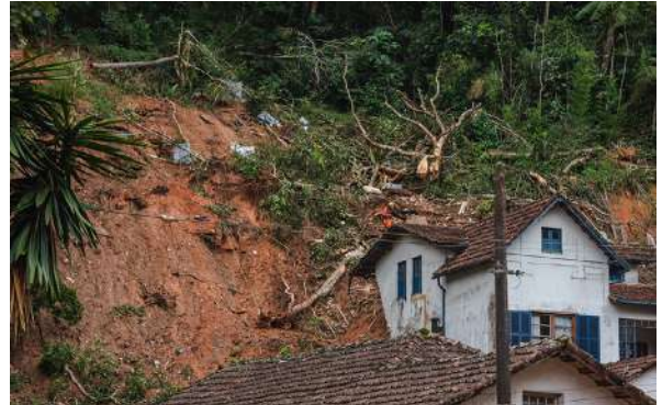
Figura 76: Residência após dia 15/02/2022.
