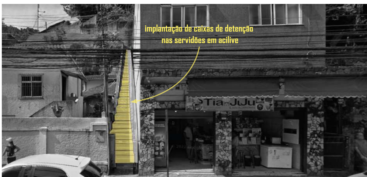
Figura 167: Escada hidráulica no trecho da Rua Washington Luís, n° 487.
