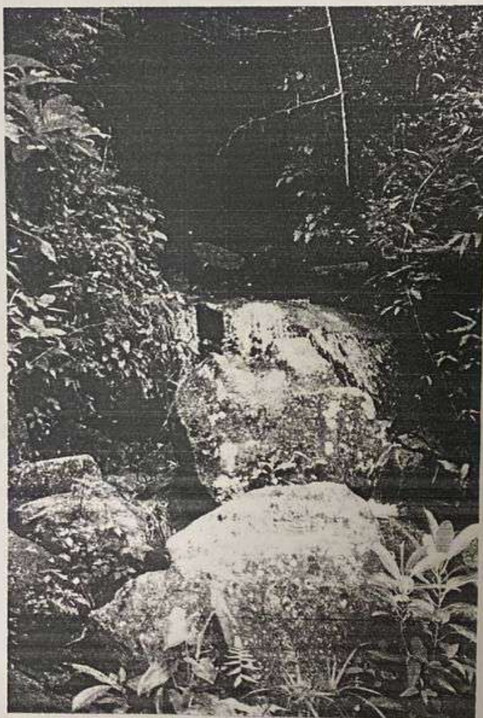
Figura 12: Barragem do Britador
