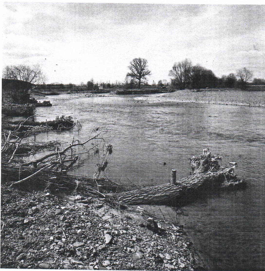
Fig. 17 Proteção das margens com troncos de árvores
