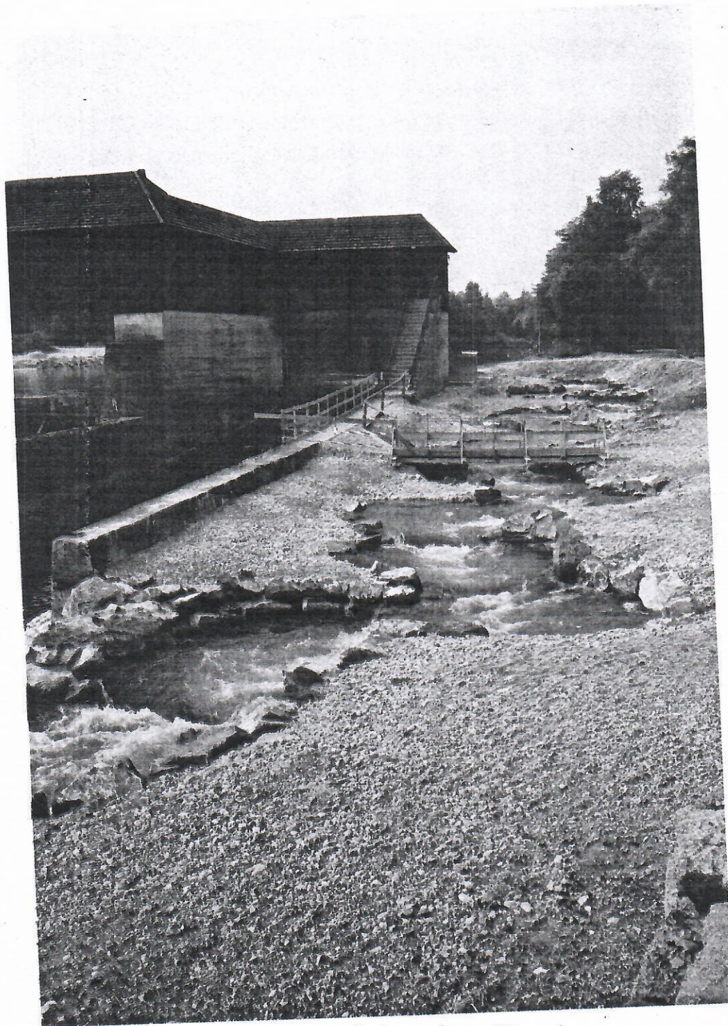
Fig. 16 Escadaria para peixe ao lado de uma barragem
