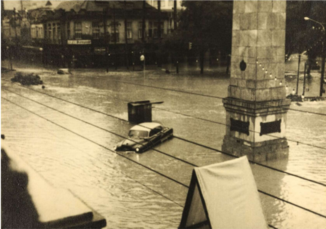
Figura 6 - Alagamento da avenida Quinze de Novembro (Atual rua do Imperador) e da Praça Don Pedro II no início do século passado
