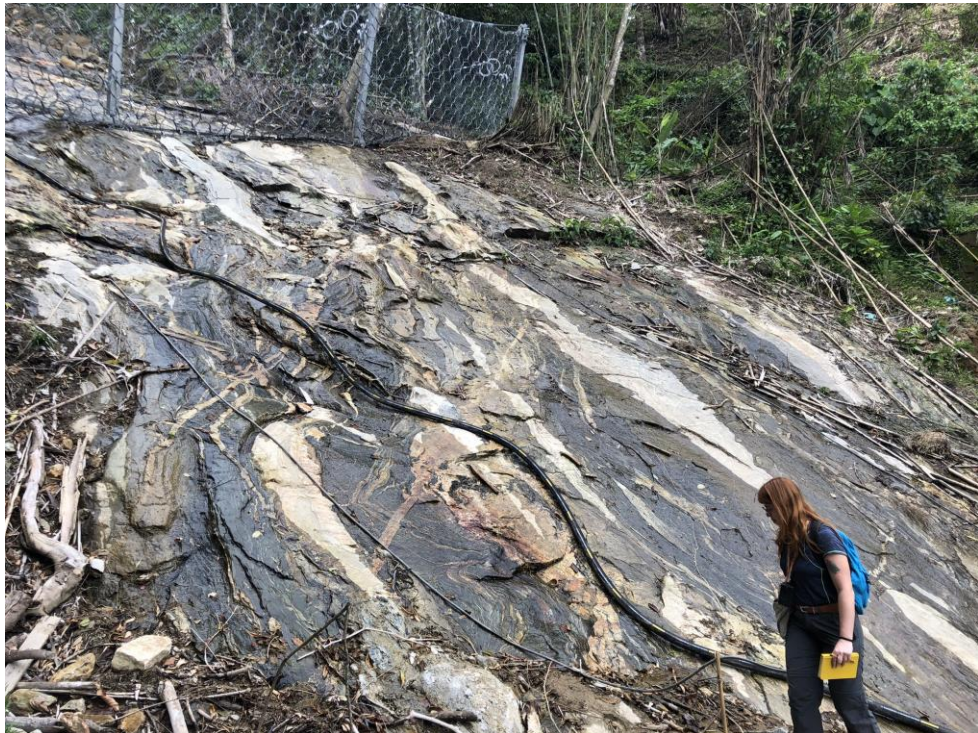
Figura 36 - B) Afloramento do Complexo Rio Negro exposto pelo corte da unidade CSmg na unidade GMma. Este local, no momento da visita, estava recebendo obras de contenção. Ponto de campo 8.
