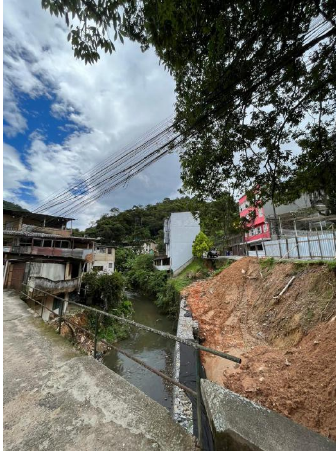
Figura 45 - Obra de contenção na curva do rio desequilibrando o balanço sedimentar. Ponto de campo 12.
