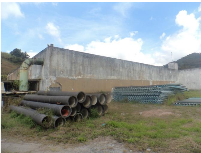
Figura 23 – Reservatório da Prata.
