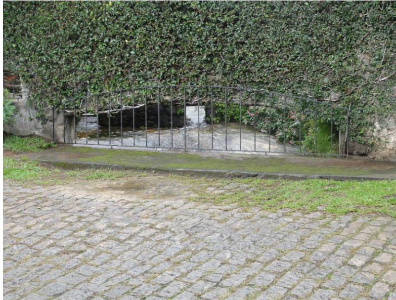
Figura 131 – Trecho de extravasamento do rio – rua Mário Freire - Parque Ingá.
