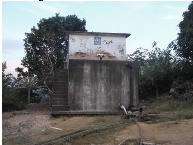
Figura 76 – Reservatório 36 m 3 .
