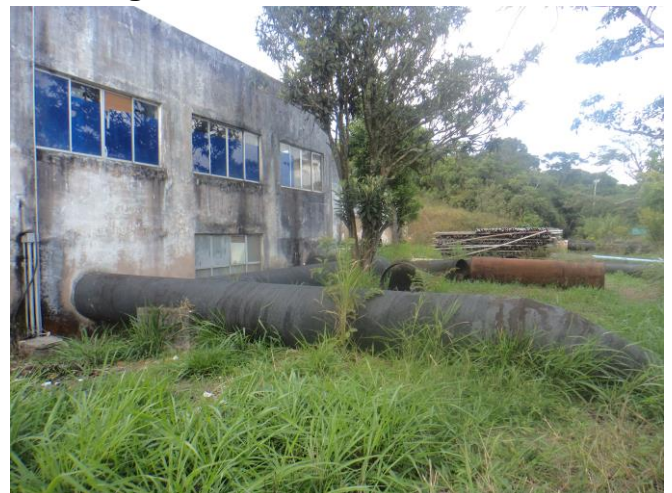
Figura 24 – Reservatório da Prata.
