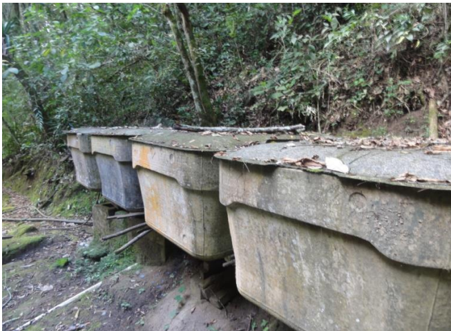
Figura 66 – Reservatórios em amianto de 1m 3 .
