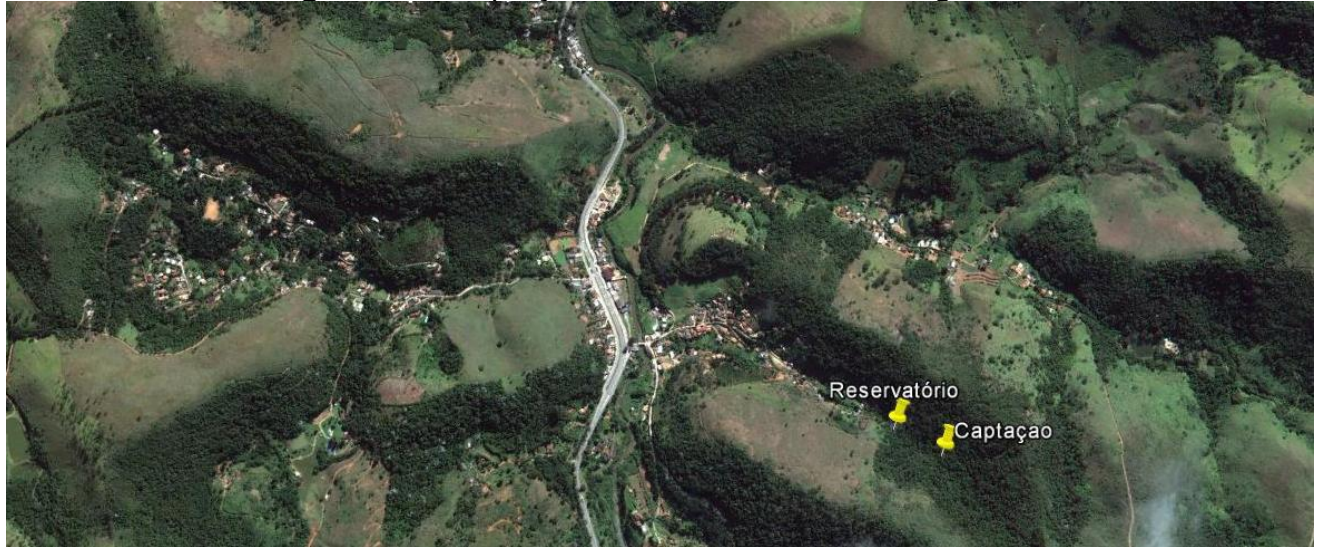
Figura 63 – Captação e reservatório de Pessegueiros.
