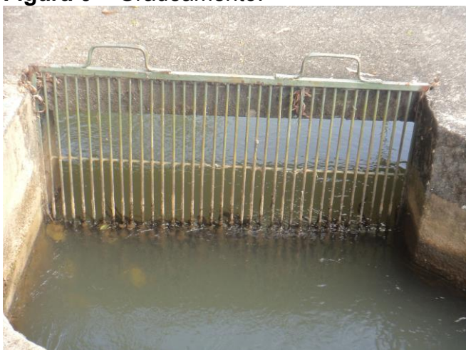
Figura 6 – Gradeamento.
