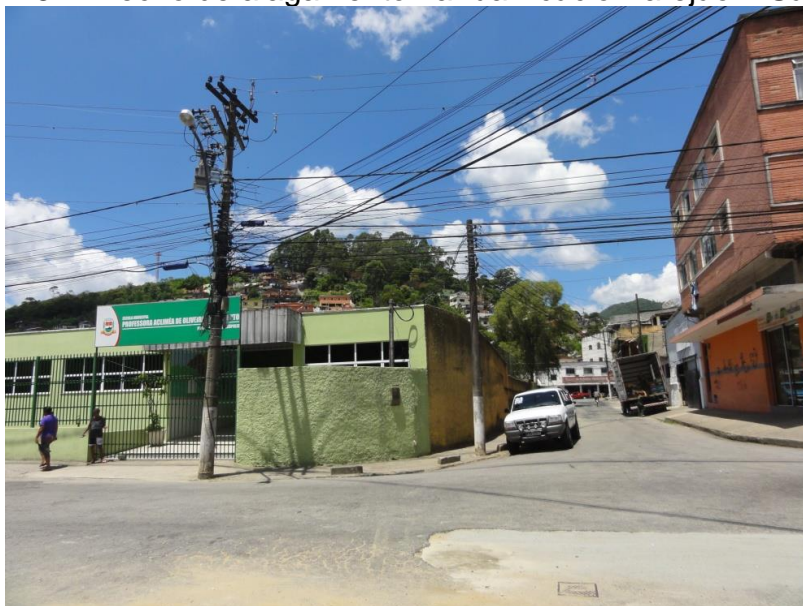
Figura 118 – Trecho de alagamento na rua Acácio Varejão – São Pedro.
