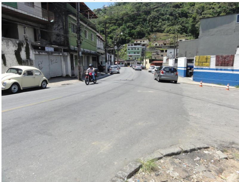
Figura 117 – Trecho de alagamento na rua Fileuterpe esquina com a rua São Martinho – São Pedro.
