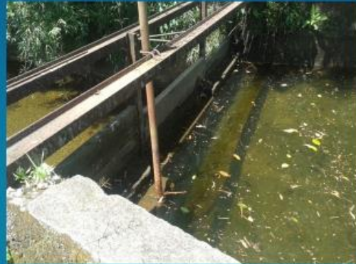
BARRAGEM JACARANDÁ INFERIOR
