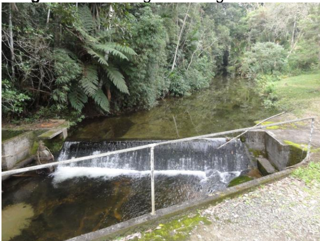
Figura 79 – Barragem – Vargem Grande.
