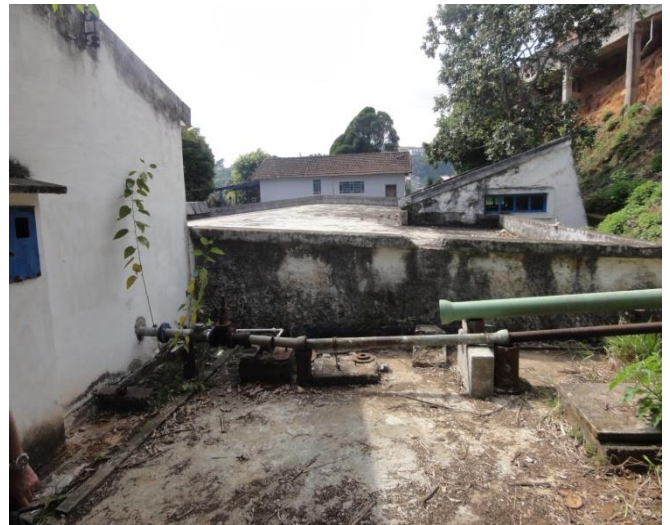
Figura 50 – Reservatório Morro dos Pinheiros.
