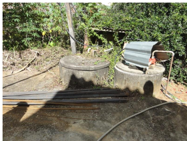
Figura 61 – Captação por poço artesiano.
