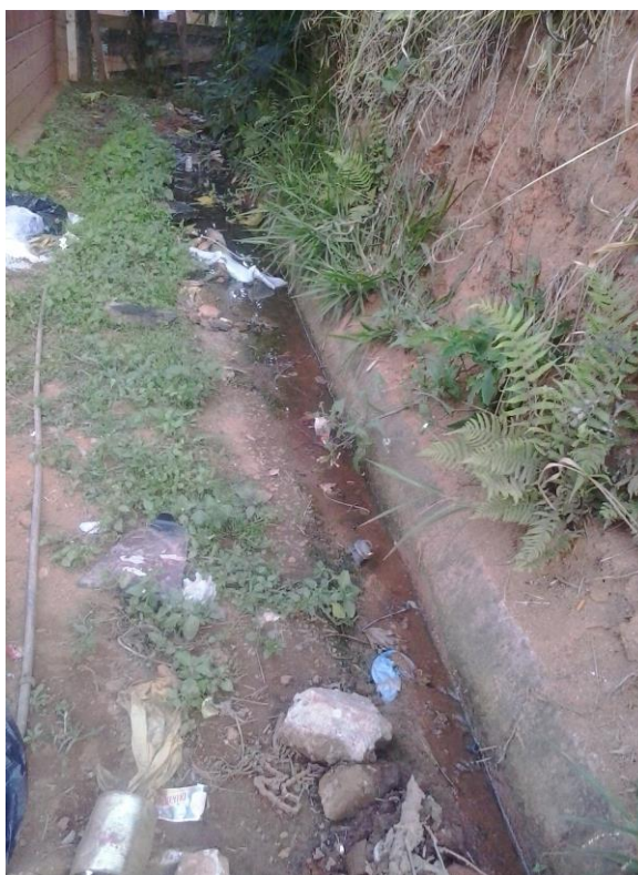
Figura 96 –Vazamento de esgoto no Bairro do Fisher.
