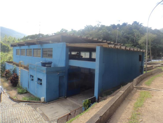
Figura 8 –Estação Elevatória de Água Bruta.
