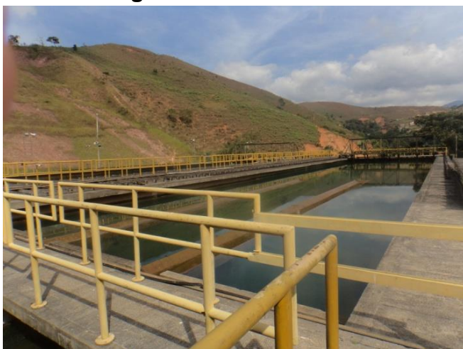
Figura 16 – Decantador.
