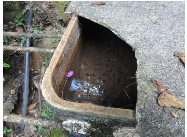
Figura 67 – Caixa de amianto com acúmulo de resíduos.
