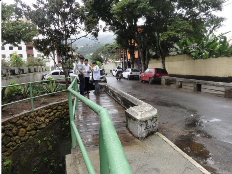
Figura 129 - Trecho de alagamento na rua Jorge Lóssio – Alto
