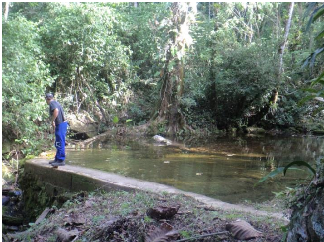
Figura 31 – Barragem do rio Taboinhas.
