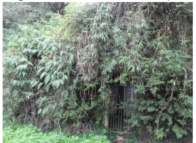
Figura 54 – Reservatório Jardim Europa.
