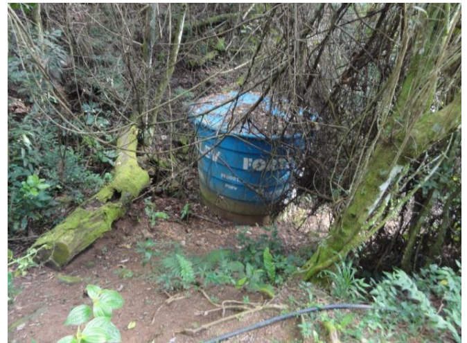
Figura 67 – Caixa de amianto com acúmulo de resíduos.
