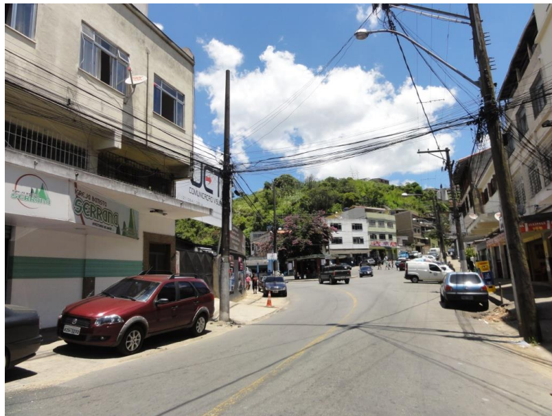
Figura 116 – Trecho de alagamento na avenida Governador Roberto Silveira– São Pedro.
