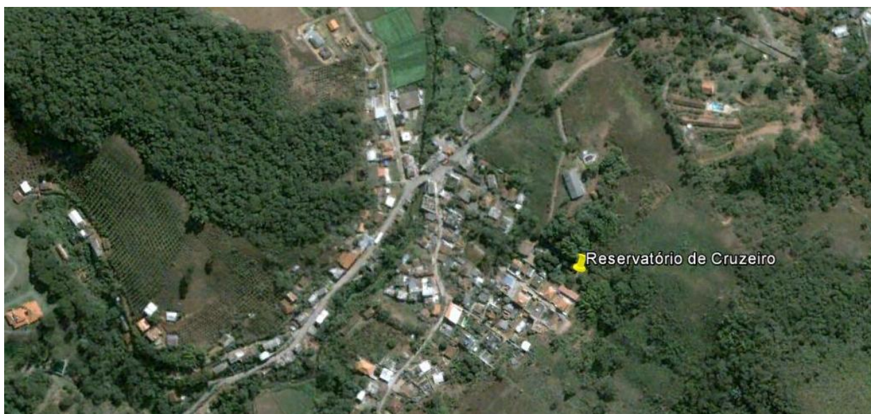
Figura 59 – Reservatório de Cruzeiro.
