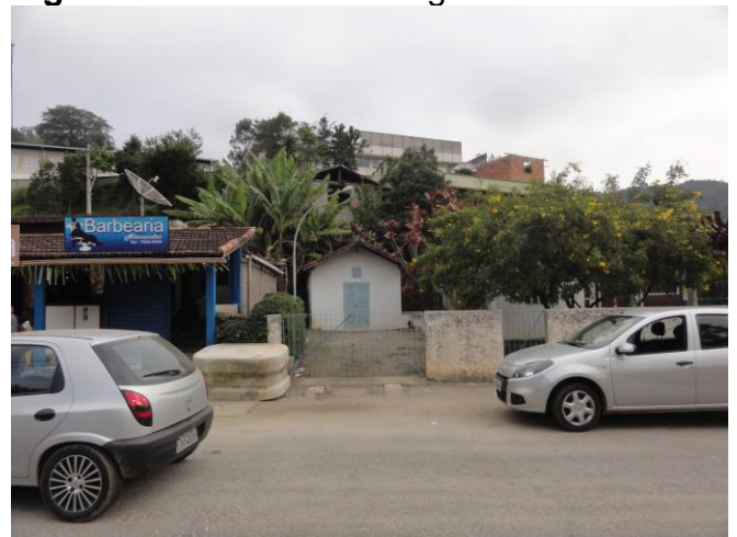
Figura 80 – Elevatória Vargem Grande.
