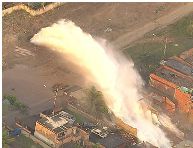
Figura 41 – Vista geral do rompimento da adutora de água tratada.
