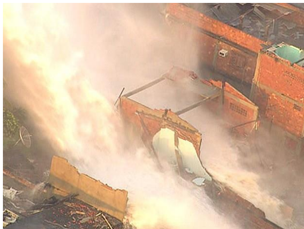
Figura 40 – Destruição de residência com o rompimento de uma adutora de água tratada.
