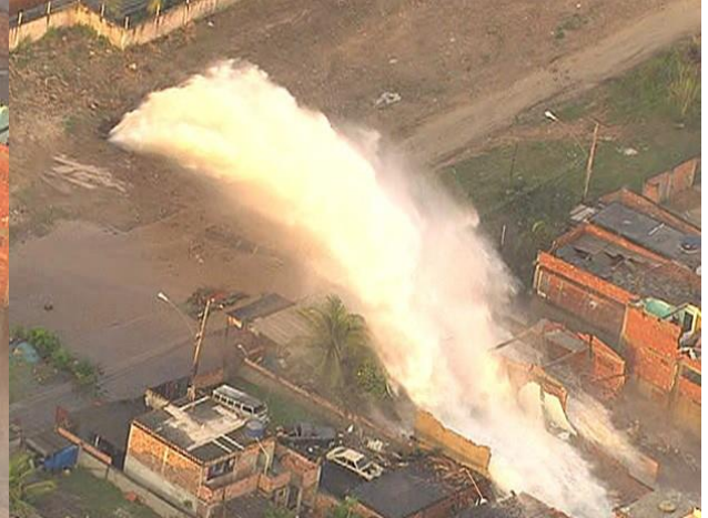
Figura 18 – Vista geral do rompimento da adutora de água tratada.
