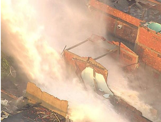
Figura 17 – Destruição de residência com o rompimento de uma adutora de água tratada.
